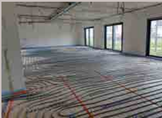
Pose du plancher chauffant-rafraichissant dans le foyer
