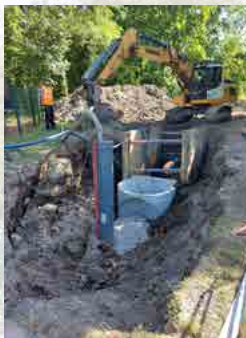
Renforcement du réseau d'assainissement rue du Chemin de Fer
