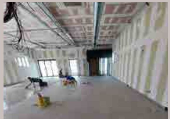
Pose du carrelage dans la partie supérette
