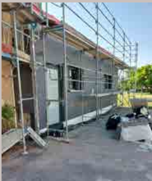
Isolation extérieure du bâtiment
