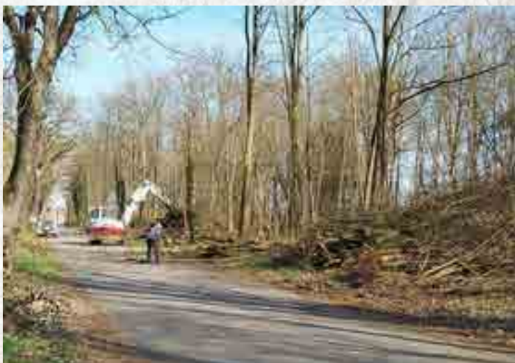
Abattage des arbres rue du Chemin de Fer pour sa sécurisation
