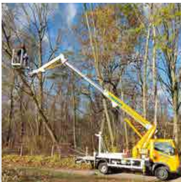
Sécurisation entrée du parcours de santé
