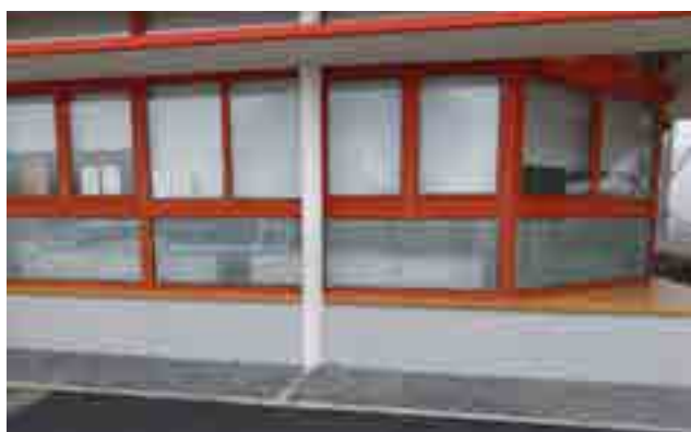
Pose de films occultants sur les fenêtres de l'école
