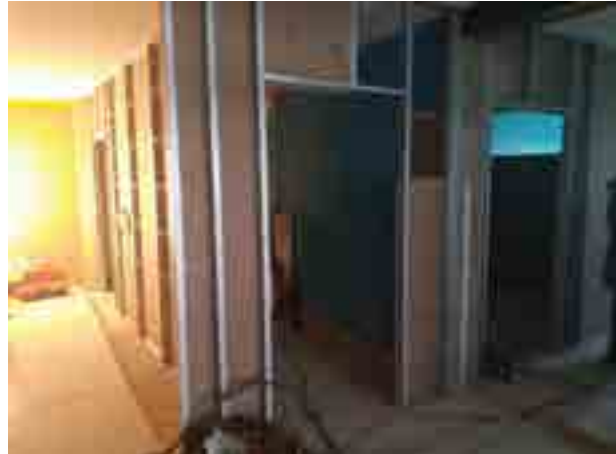
Travaux pour la salle de restauration
