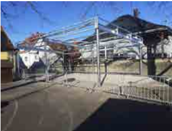
Installation nouveau préau
